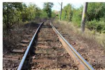
Foto nr.6 – prismă de piatră spartă cu zonă colmatată
