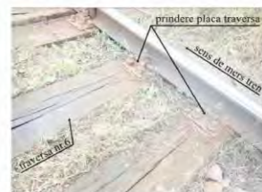
Foto nr.7 - Traversa nr.6 (detaliu la interiorul firului exterior al curbei)
