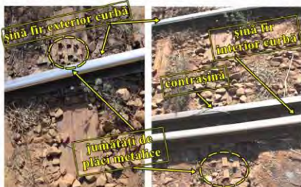
Foto nr. 4 – jumătăți de plăci metalice montate înspre exteriorul căii pe capetele traverselor
