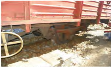
Foto nr.19 – Osia deraiată a vaionului al 12-lea (prima osie în sensul de mers)
