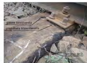
Foto nr.5 - traversa nr.0 (detaliu la interiorul firului exterior al curbei)
