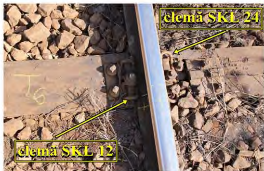
Foto nr.3 – șină fixată de placa metalică cu cleme elastice tip SKL 12 și SKL 24
