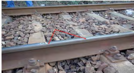
foto 11: urma de cădere a roții în exteriorul căii
