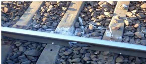
foto 2-4: afectarea suprastructurii feroviare
