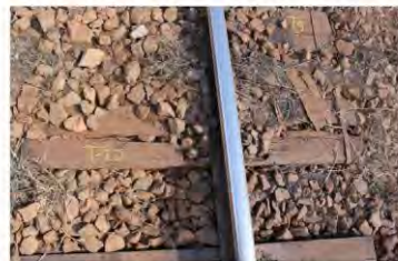
Foto nr.5 – traversă necorespunzătoare
