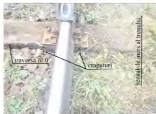
Foto nr.4 - traversa nr.0 (detaliu fir exterior curbă)
