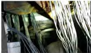
Imaginea 9 – cabluri electrice arse, aflate sub cabina de conducere în zona rezervorului
