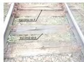
Foto nr.6 - Traversa nr.4 și nr.6 (detaliu la interiorul căii)
