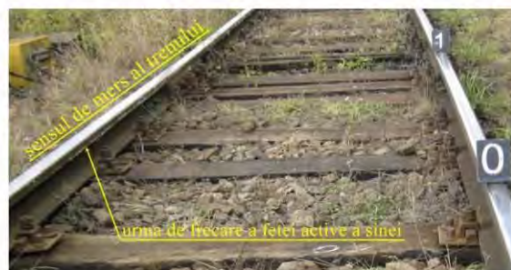
Foto nr. 3 – punctele de cădere și de escaladare
