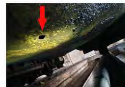
Imaginea 7 – rezervorul de motorină prezenta un orificiu, perforat dinspre exterior spre interior;
